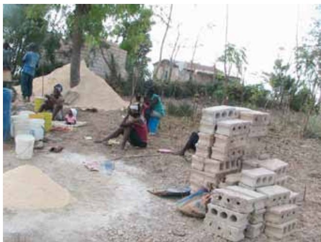
Auto-construction : chantier en auto-construction assistée.
