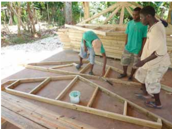
Préfabrication : fermes modulaires avec plaquage pour le contreventement.
