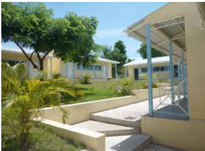
Ecole primaire : reconstruction de qualité d'un complexe scolaire à Jacmel.
