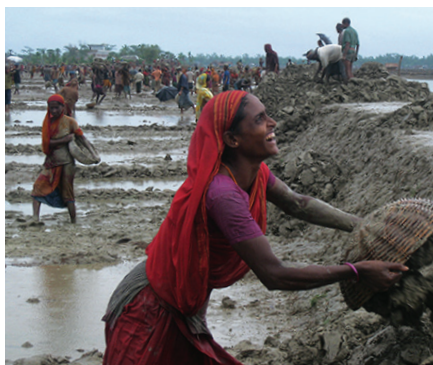
Construction d'une digue au Bangladesh.
