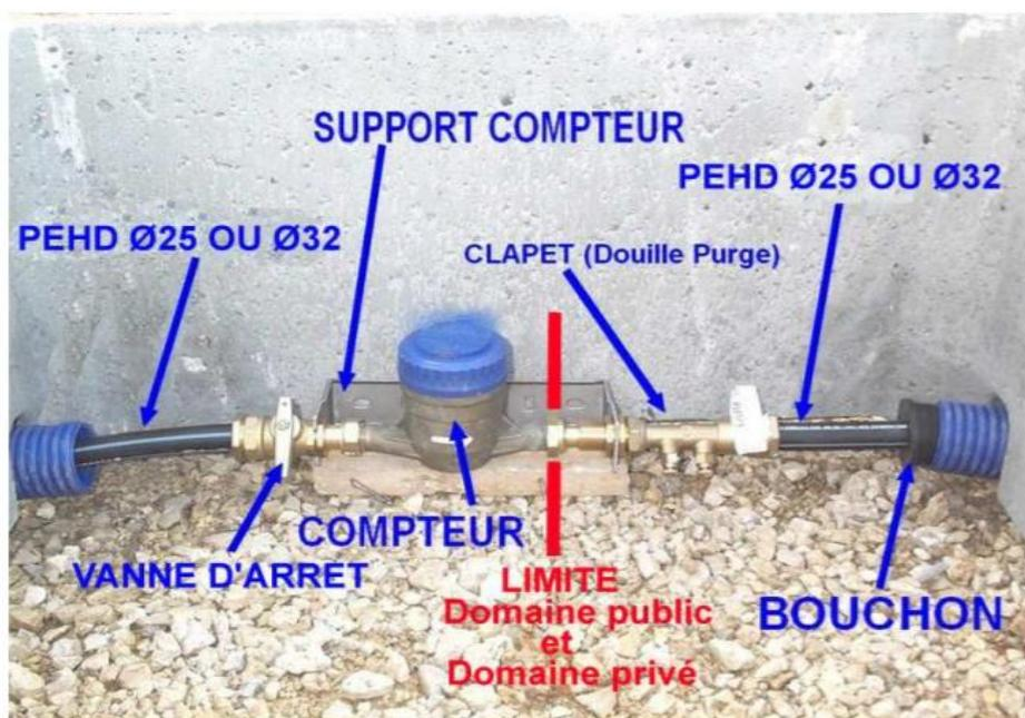
Exemple d'un raccordement classique. Source : Guide technique de l'eau potable<sup>67</sup>
