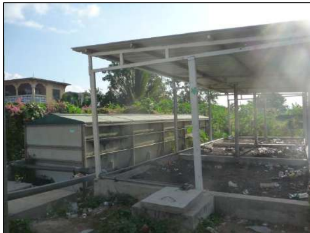
Figure 6- Station de traitement des eaux usées par bio disques à Petite-Terre. Non entretenue par le SIEAM. ©Sophie Oddo
