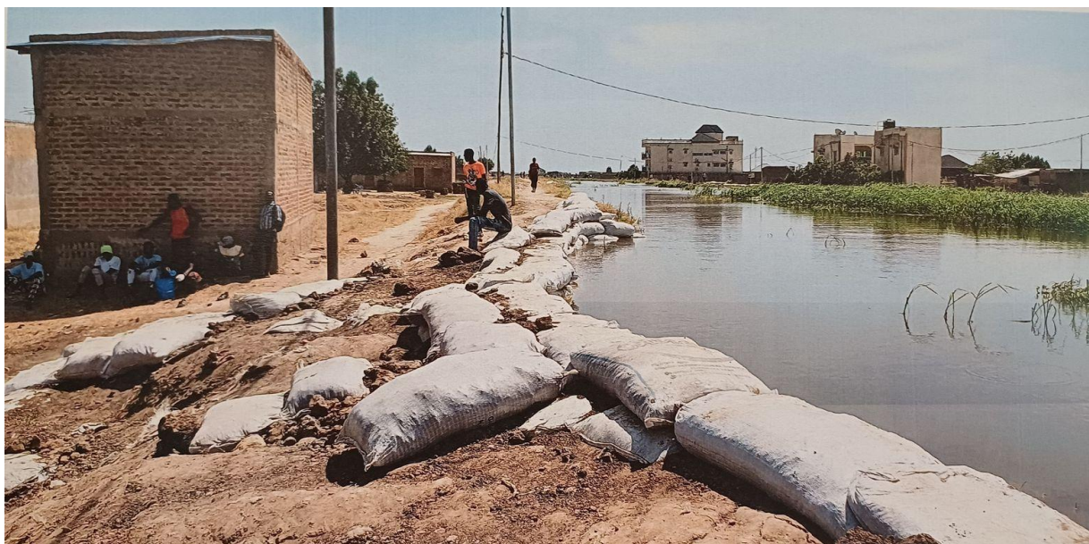
Image 9. Digue de Digangali, octobre 2024, © Photo des auteurs.
