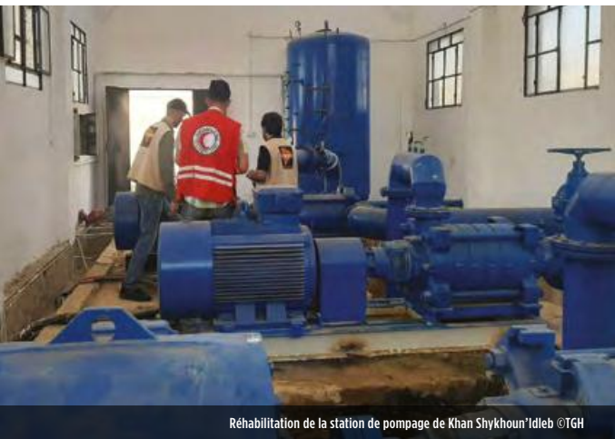
Réhabilitation de la station de pompage de Khan Shykhoun'Idleb ©TGH
