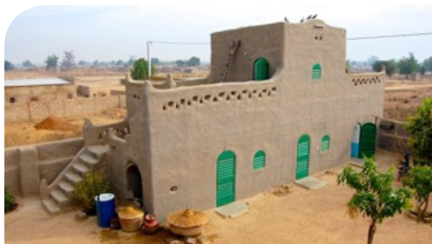
Bâtiment en Voûte Nubienne
