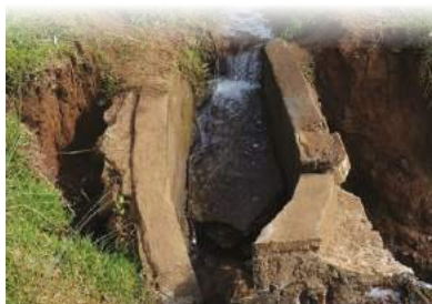
Ouvrage dégradé suite à une crue
