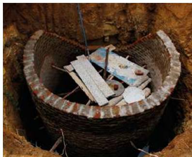
Construction d'un puits, Sri Lanka
