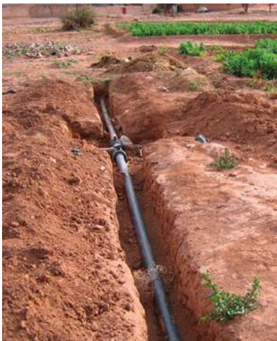
Canalisation PVC enterrée, Maroc
