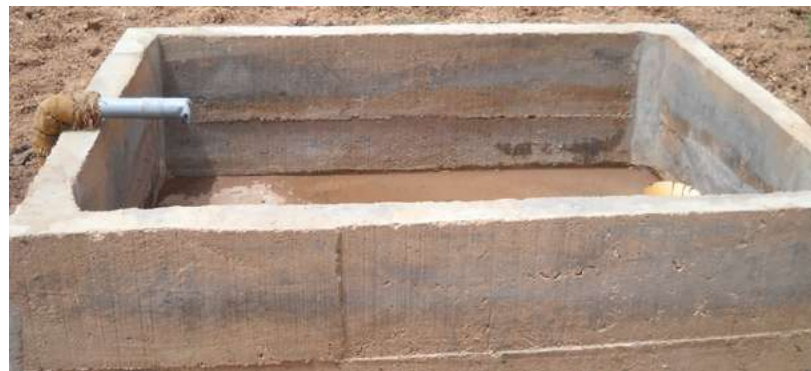
Bassin de reprise, Niger
