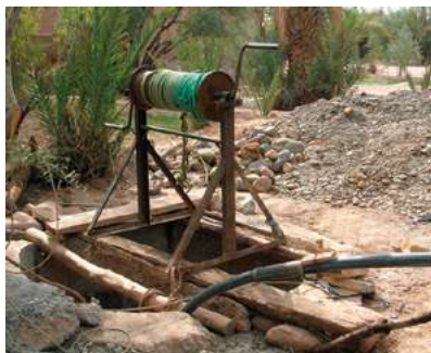
Construction d'un puits, Maroc
