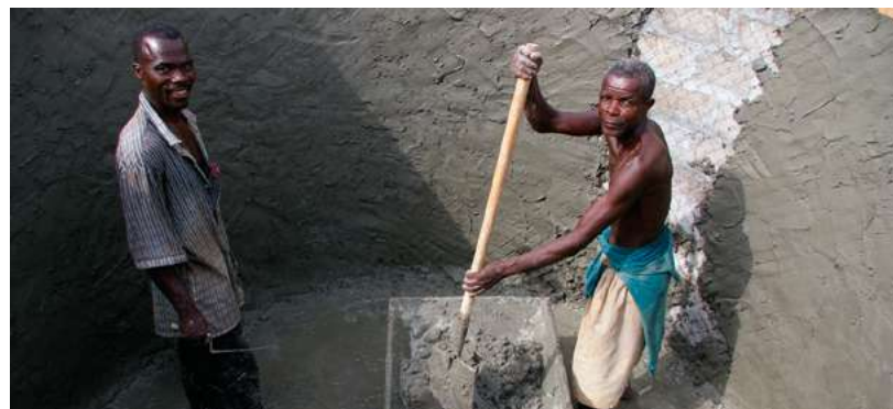
Construction d'une citerne, RD Congo
