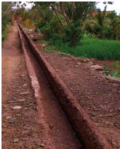
Canal bétonné, Maroc
