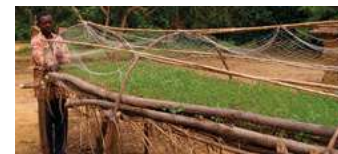
Mise en place d'un filet de protection
