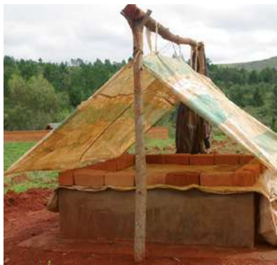
fosse à biofertilisant liquide maçonnée, Madagascar
