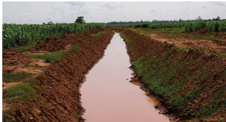
Canal d'amenée d'eau en cours d'aménagement, Cambodge
