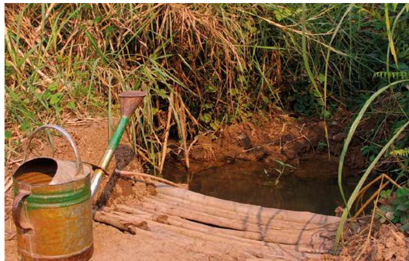
Point de captage aménagé, RD Congo
