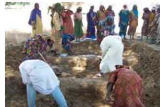
Réalisation des fosses à compost, Niger
